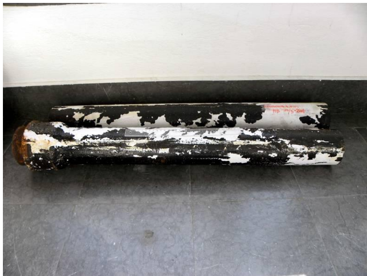
Figur 87. Översiktsbild av de erhållna proven bestående av ett DN100-rör med en längd av cirka 80 cm samt ett DN100-rör med muff/koppling med en längd av 100 cm.
