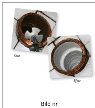
Figur 7. Före och efter applicering av plastmassa med sprutmetoden.
