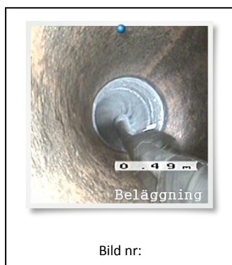
Figur 8. Borstmetoden använder epoxiplast som borstas på av roterande borstar.
