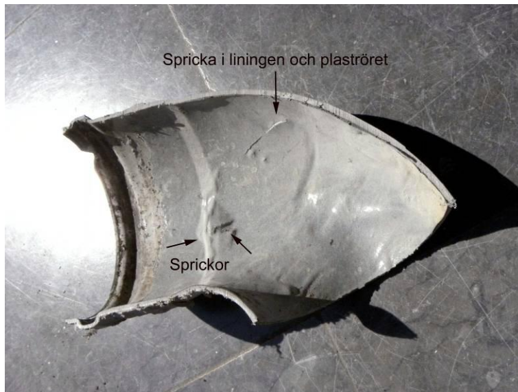
Figur 34. Förstoring av den ena halvan av den uppsågade rörkröken. Den övre sprickan uppkom tydligen på grund av yttre åverkan. Här sprack plaströret sprött och tryckte in liningen. Den nedre sprickan verkade vara av annan karaktär (se figurerna 35 och 36).
