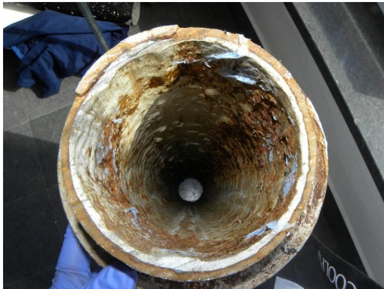
Figur 83. Invändig vy sedd från muff/kopplingsidan. Liningen täckte muffövergången bra.
