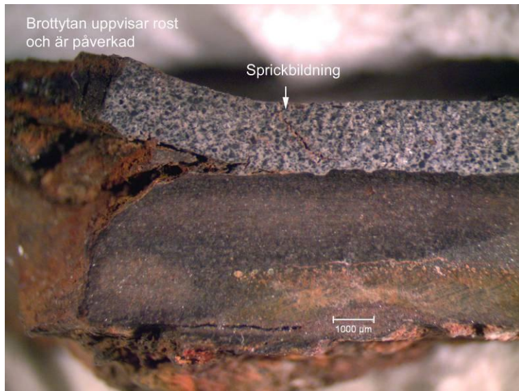
Figur 9. Polerat tvärsnitt som visar liningen och gjutjärnsröret där den genomgående sprickan bildades. Brottytan hos liningen uppvisar förekomst av korrosionsprodukter, och materialet verkar vara påverkat vilket indikerar att detta brott inte skett i samband med provtagningen utan tidigare. En större spricka observerades även i anslutning till den genomgående sprickan. Liningens tjocklek är i detta område större än 1 mm.
