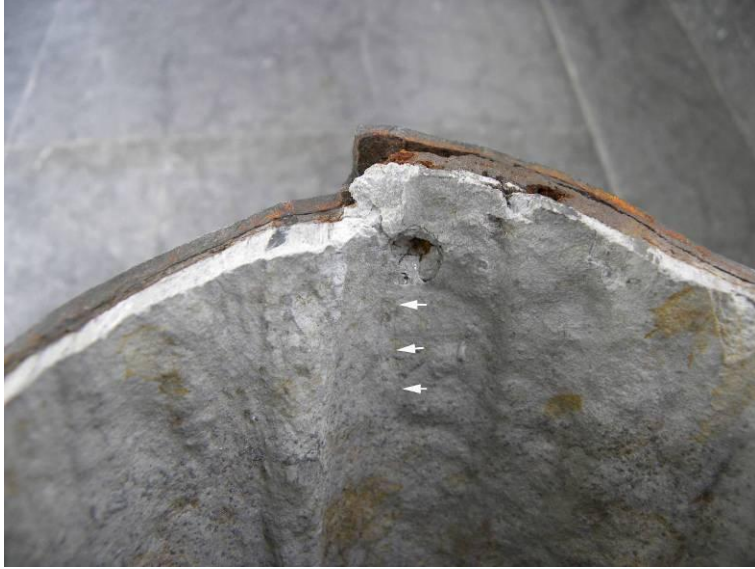
Figur 69. Skada i form av spricka och hålighet som bildats i samband med provtagningen.
