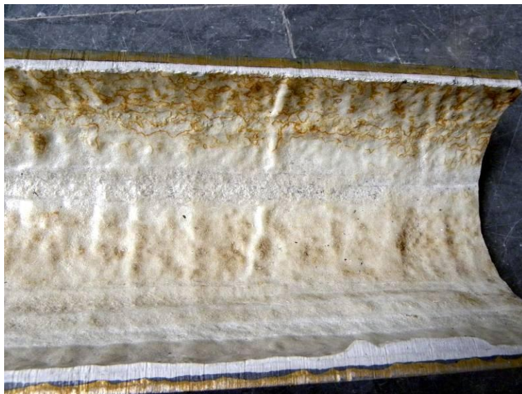
Figur 85. Närbild av rörets inneryta. Viss beläggning och missfärgning förekom. Ytan var fortfarande glansig. Tjockleksvariationer fanns, men var förhållandevis små. Vidhäftningen till underlaget verkade vara god, inga lösa korrosionsprodukter var synliga.
