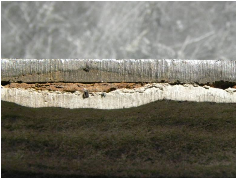
Figur 71. Tvärsnitt genom lining och gjutjärnsröret. Gjutjärnsröret visade grafitering till olika grader längs sågningskanten samt förekomsten av lösa korrosionsprodukter. Liningen satt här löst mot det korroderade skiktet.
