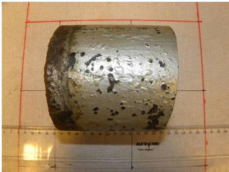
Figur 55. Översiktsbild av det erhållna provet. Provet bestod av ett DN100-rör med en längd av cirka 18 cm. Den vänstra delen satt i en muff/koppling.
