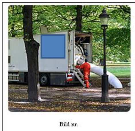
Figur 3. Relining av markrör har pågått länge, men har kallats schaktfri förnyelse av ledningssystem eller No Dig.
