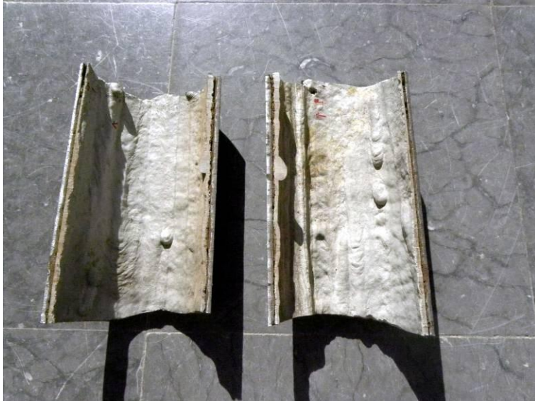
Figur 70. Översiktsbild av det uppsågade röret. Inga skador som sprickor i axiell eller omkretsriktning hittades.
